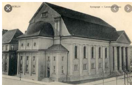
Die Synagoge Levetzowstraße
