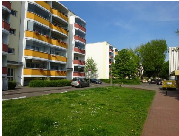
Blick auf die Häuser Falkenberger Str. 11 - 15 in Weißensee. Hier befand sich bis ca. 1974 die Hohenschönhauser Str. 84.
